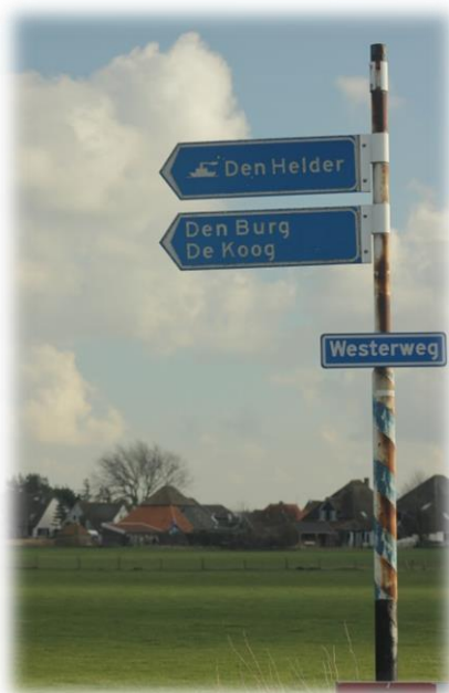
Afbeelding 3.2 Voorbeeld van kwaliteit 'D' drager
